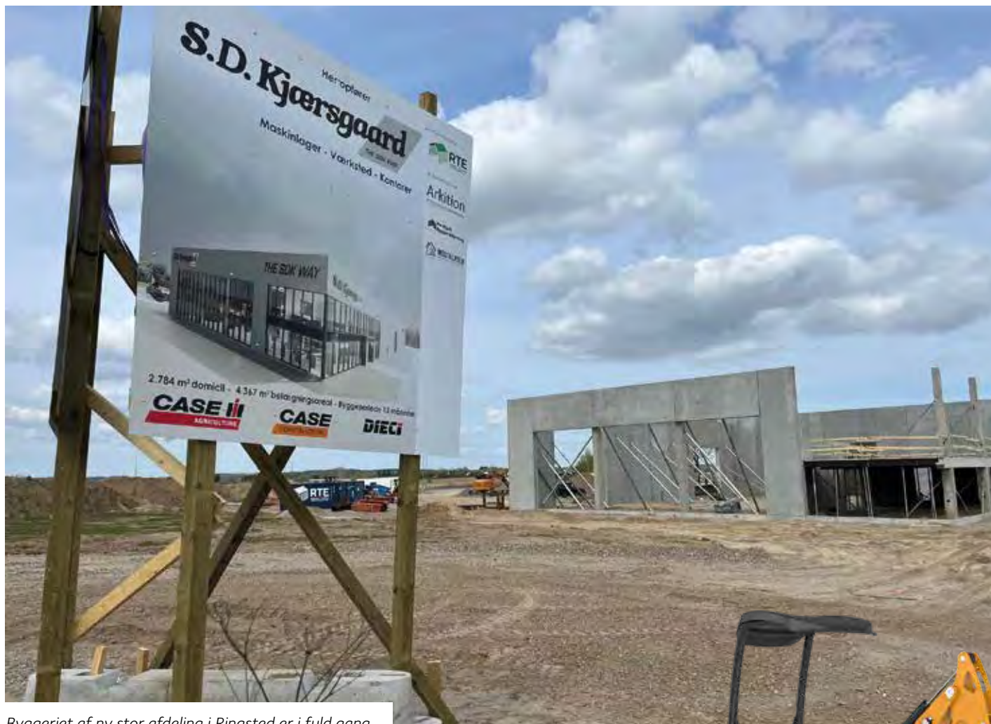
Byggeriet af ny stor afdeling i Ringsted er i fuld gang.
