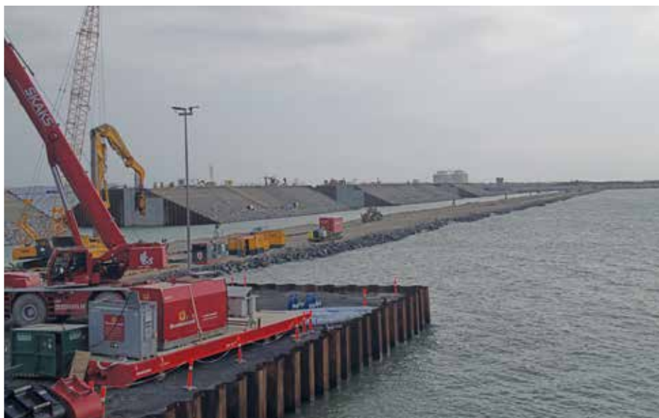
Nu er der kommet vand i de store bassiner, hvor de færdige tunnelementer skal sejles ud fra.
