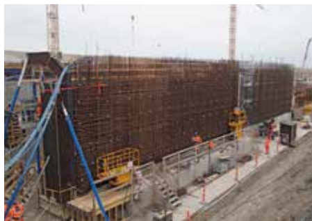
Arbejdet med tunnelportalen – hvor biler og tog kører ned i selve tunnelen – er i fuld gang.
