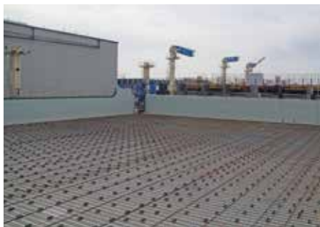
Her forberedes støbning af et af specialelementerne.
