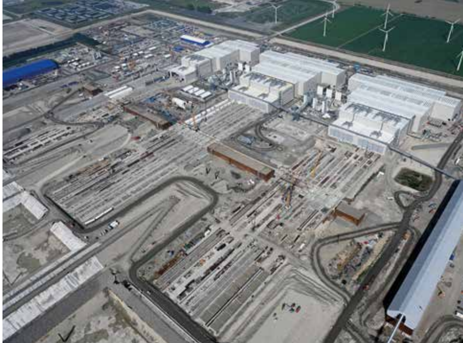
Tunnelfabrik og tørdok set fra oven.
