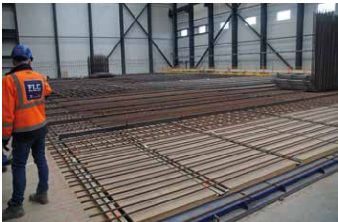
Bundpladen til det næste segment er ved at blive forberedt.
