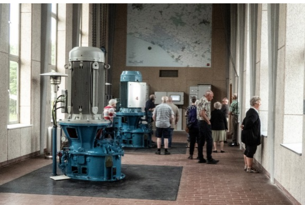
Kramnitse pumpestation der sørger for at holde det sydlige Lolland tør. Stationen har en kapacitet på 20 m 3 i sekundet.
